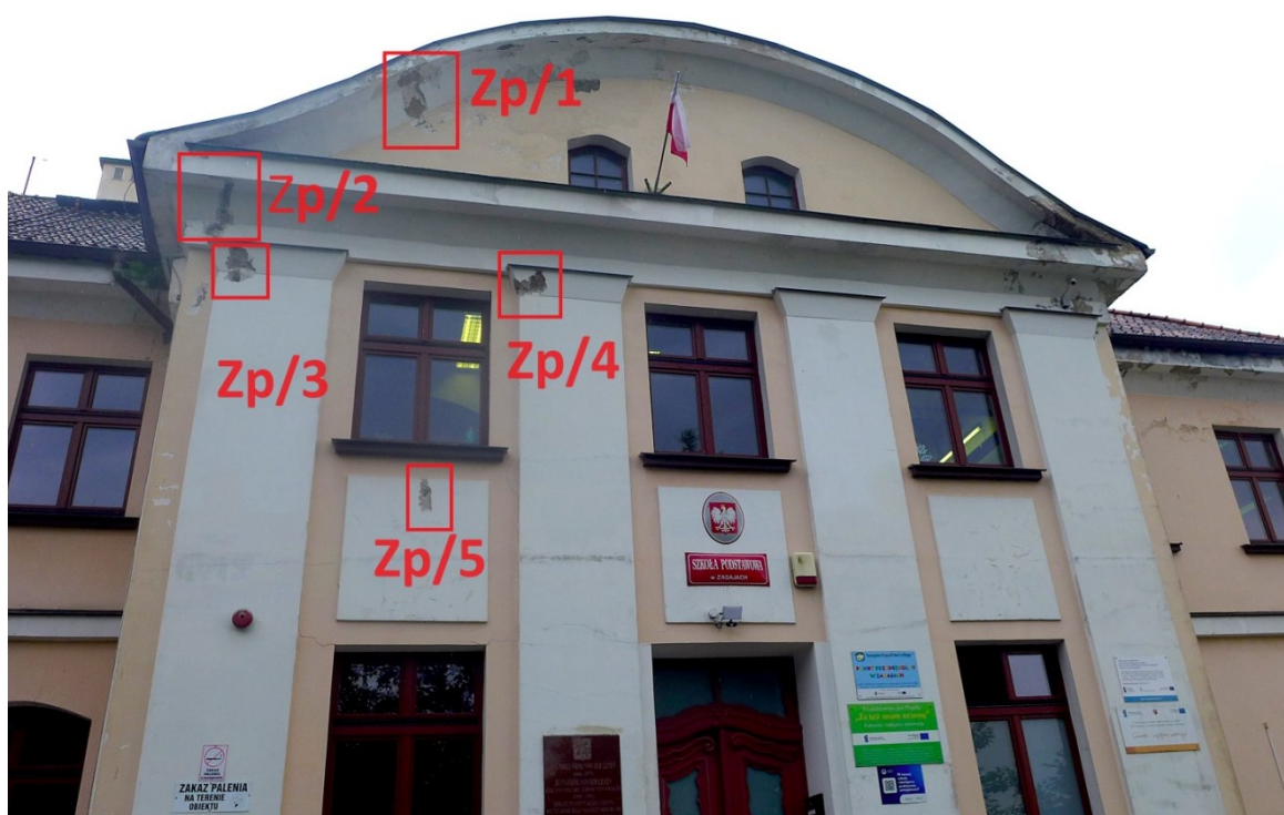
Ryzalit centralny, zaznaczono miejsca wykonania odkrywek sondażowych.
